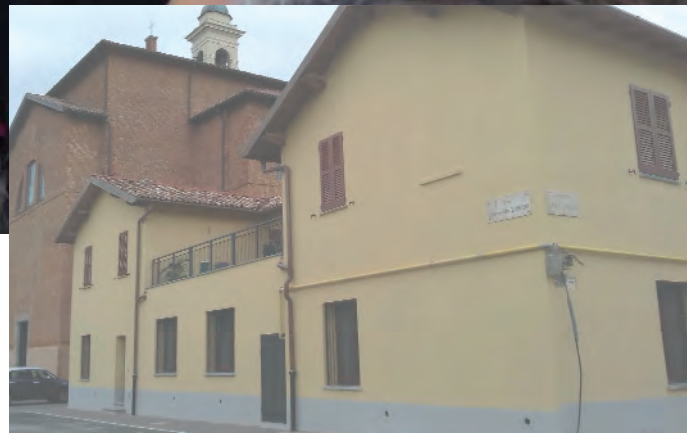
La canonica ristrutturata che ospita la Casa Martignoni
